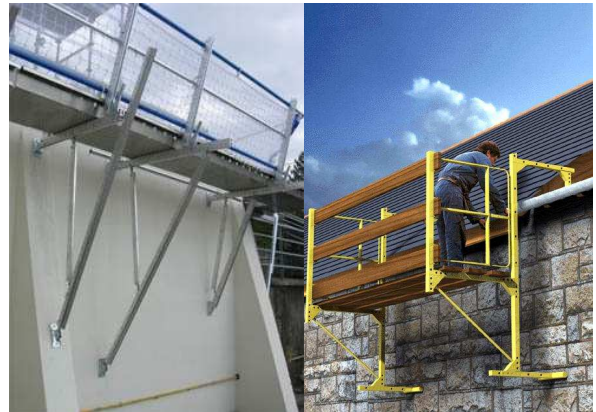
Echafaudage en encorbellement
