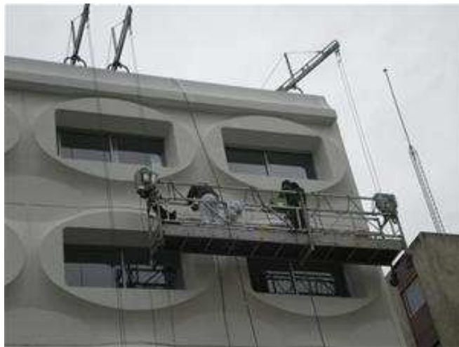
Echafaudage suspendus sur câbles
