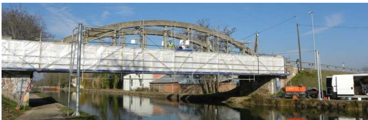
Les échafaudages suspendu
